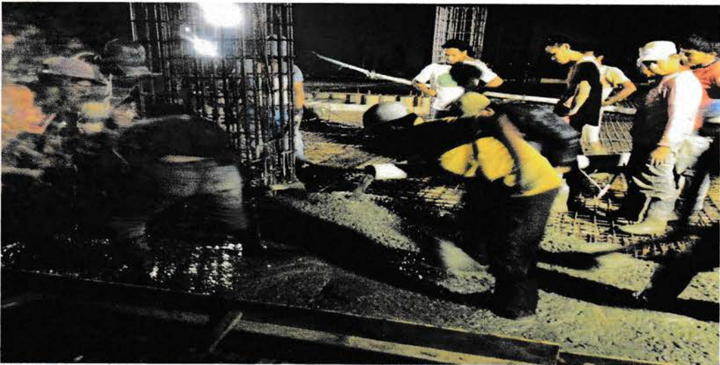
Gambar 3.9. pekerjaan pengecoran
