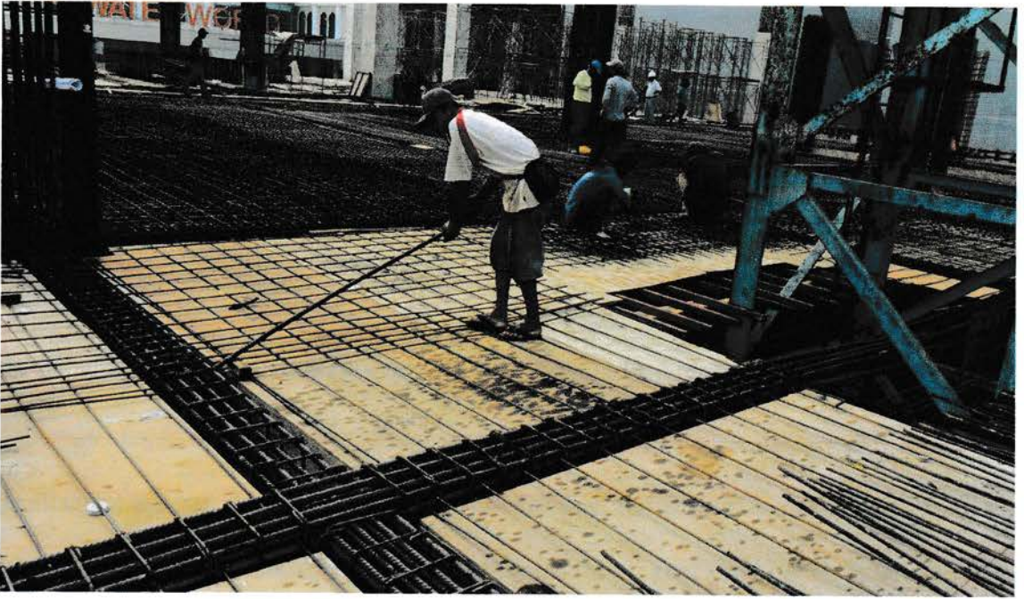
Gambar 3.7. Tulangan plat lantai
