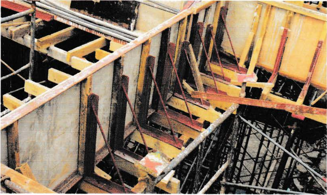
Gambar Bekesting Plat Lantai Sumber : Data Lapangan 2015
