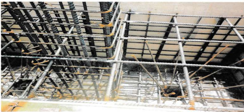
Gbr. 2. 1Pengikatan Pembesian kolom dan tiang pancang
