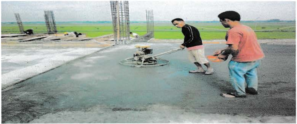
Gbr. 7 Penghalusan pengecoran pada lantai I
