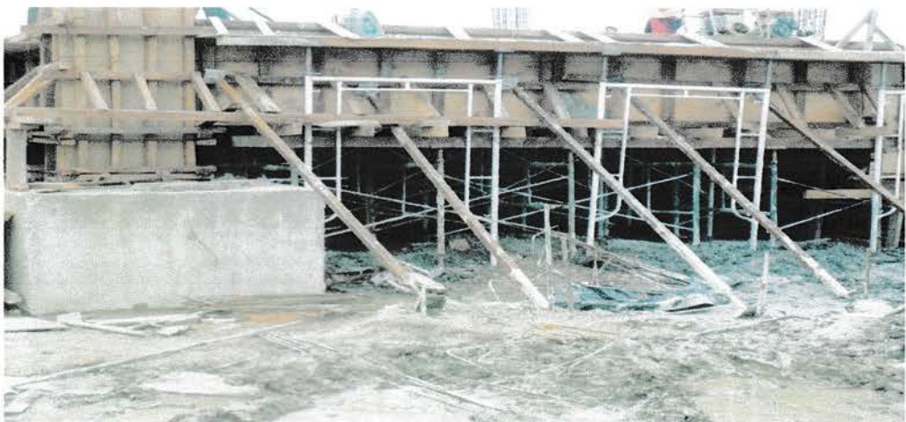
Gbr. 6. 1 Pembuatan bakisting pada balok
