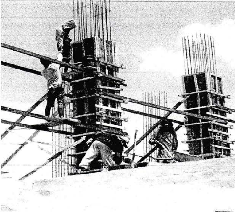
Gambar 2 :Proses Pengecoran Kolom
