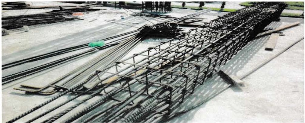
Gbr. 8 Kerangkaian pembesian balok
