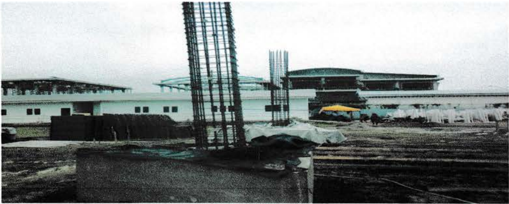
Gbr. 3 Hasil pengecoran pembesian tybim dan kolom
