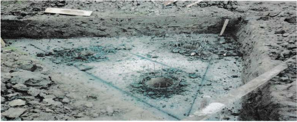
Gbr. 2. 5 Penggalian tanah untuk pembesian tybim
