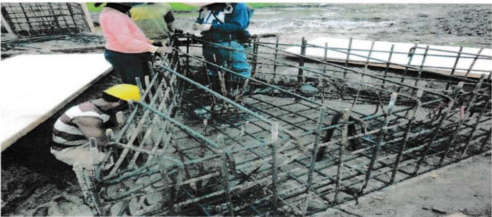
Gbr. 2. 4 Rangkaian pembesian tybim dan tiang pancang
