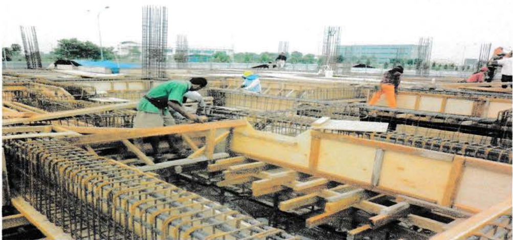
Gbr. 6. 1 Pembuatan bakisting pada balok
