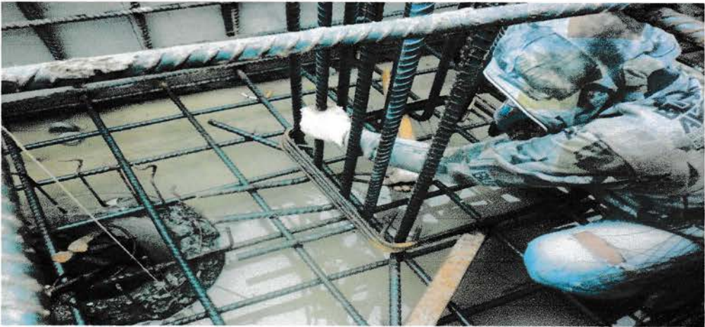
Gbr. 2. 3Pengikatan pembesian antara tiang pancang, tybim, dan kolom
