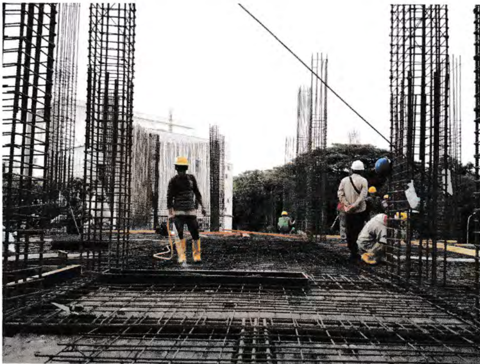
Gambar 6 : Pembersihan Bekisting dan Pembesian Plat Lantai Lokasi : Universitas Negeri Medan
