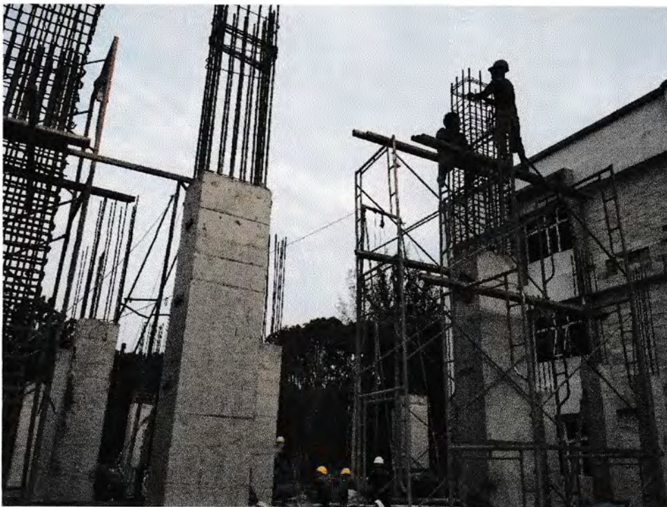
Gambar 2 : Pemasangan Besi Sengkang pada Kolom
