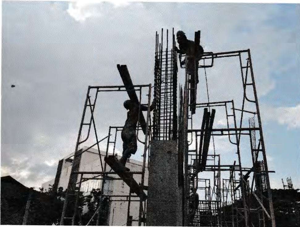
Gambar 3 : Pemasangan Besi Sengkang pada Kolom Lokasi : Universitas Negeri Medan
