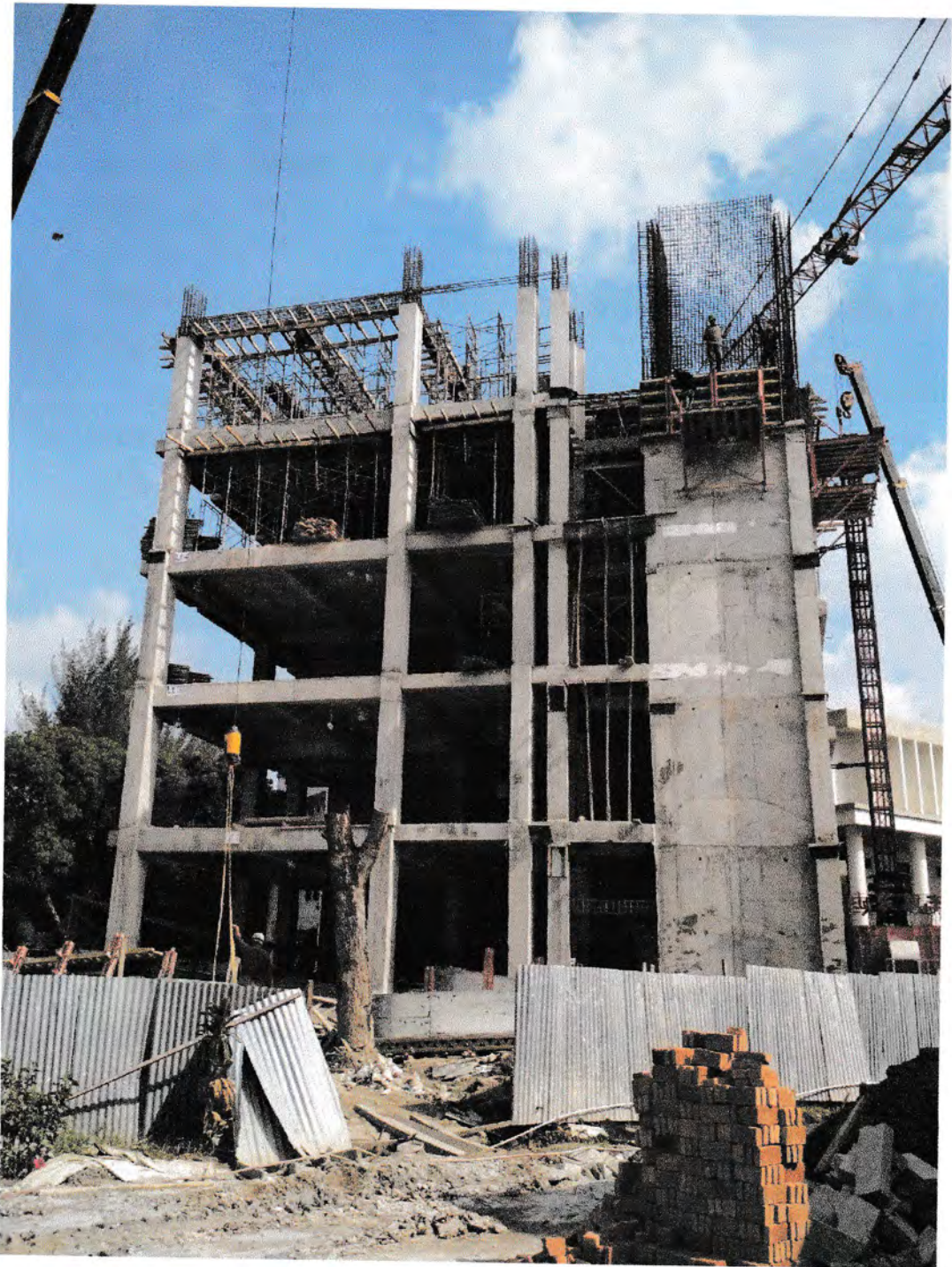
Gambar 11 : Tampak Samping Progres Pembangunan Gedung Kuliah FMIPA Lokasi : Universitas Negeri Medan
