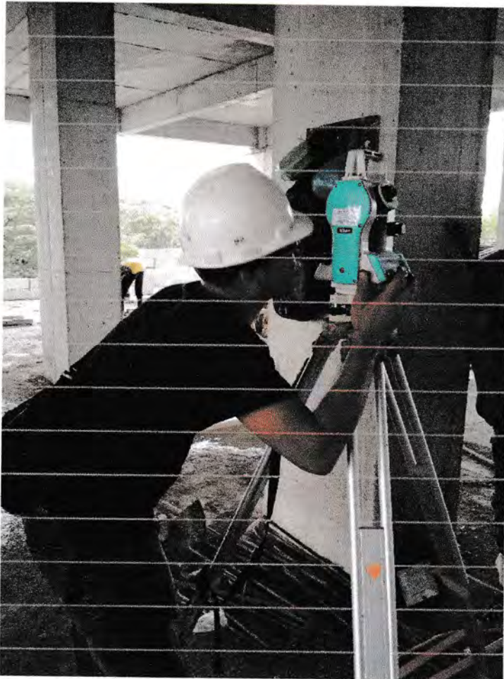
Gambar 3.19 Penentuan As dengan Waterpass
