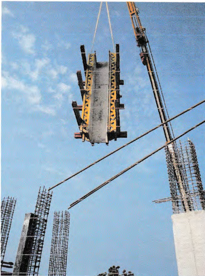
Gambar 3.23 Pemasangan Bekisting
