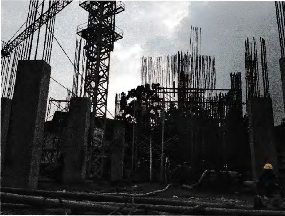
Gambar 1 : Pemasangan Besi Dinding Shear Wall
