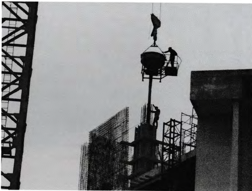
Gambar 9 : Pengecoran Kolom Lokasi : Universitas Negeri Medan
