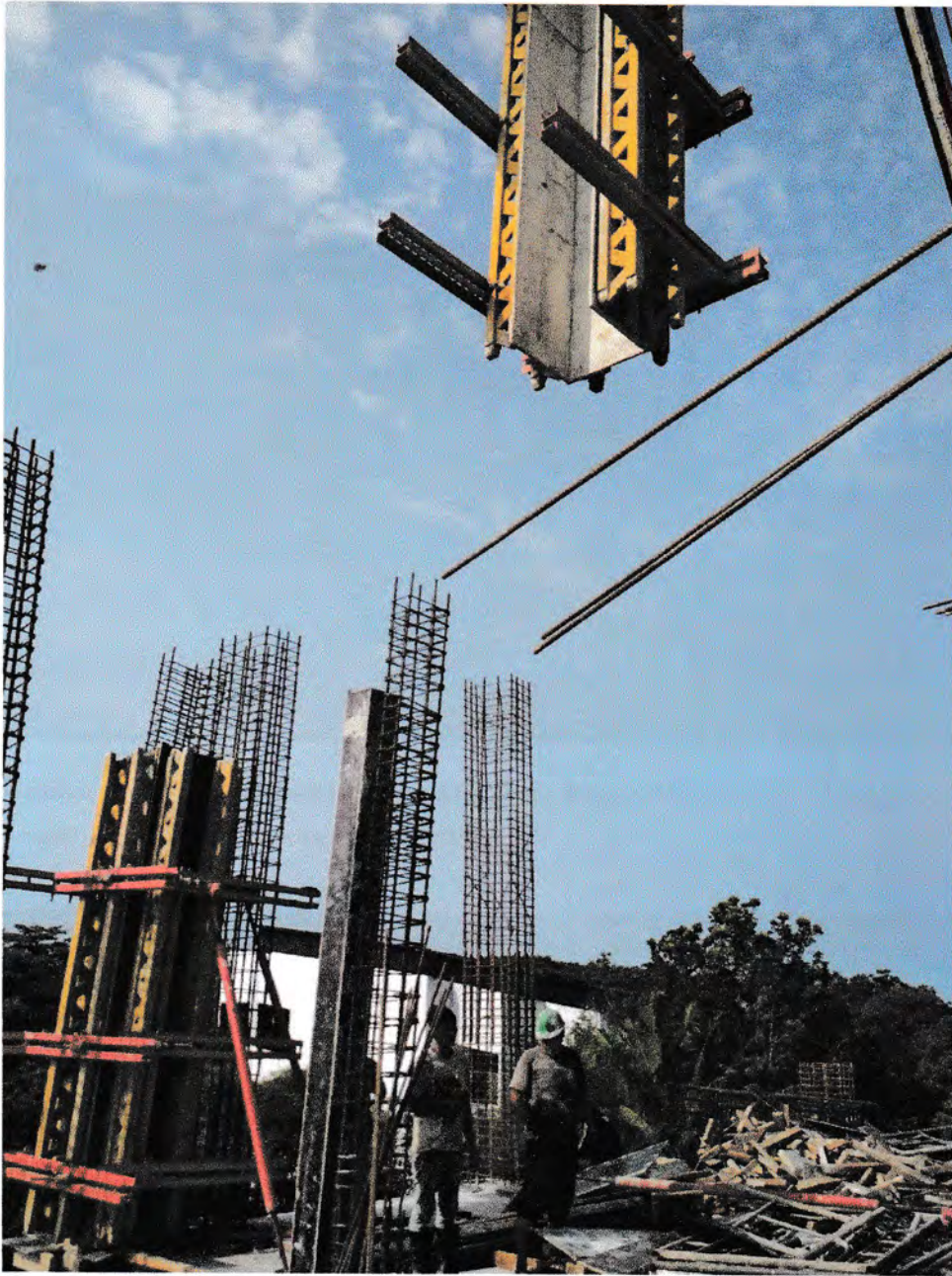
Gambar 7 : Pemasangan Bekisting Kolom
