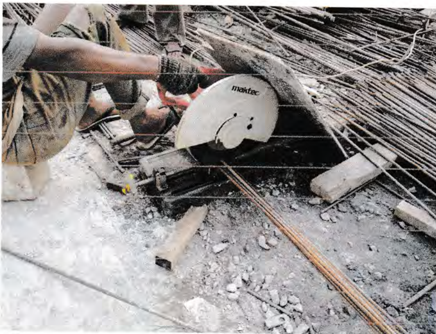
Gambar 3.16 Bar Cutter (Pemotong Tulangan)
