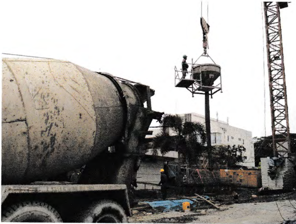
Gambar 8 : Pengambilan Beton dari Truck Ready Mix Lokasi : Universitas Negeri Medan
