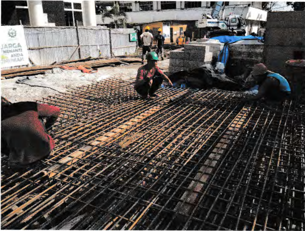
Gambar 5 : Perakitan Besi Plat Lantai Lokasi : Universitas Negeri Medan
