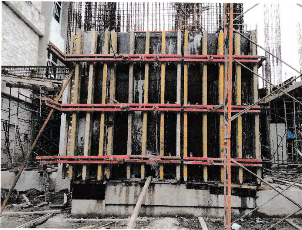
Gambar 4 : Bekisting Dinding dan Pengecoran Dinding Shear Wall Lokasi : Universitas Negeri Medan
