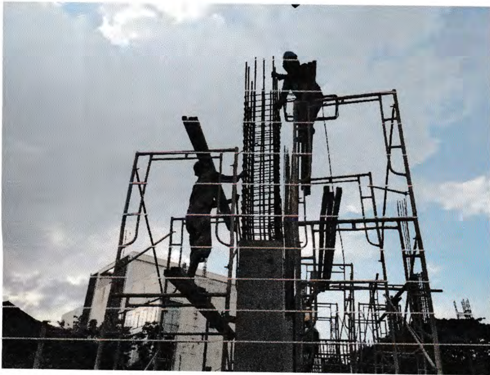
Gambar 3.21 Pembesian Kolom
