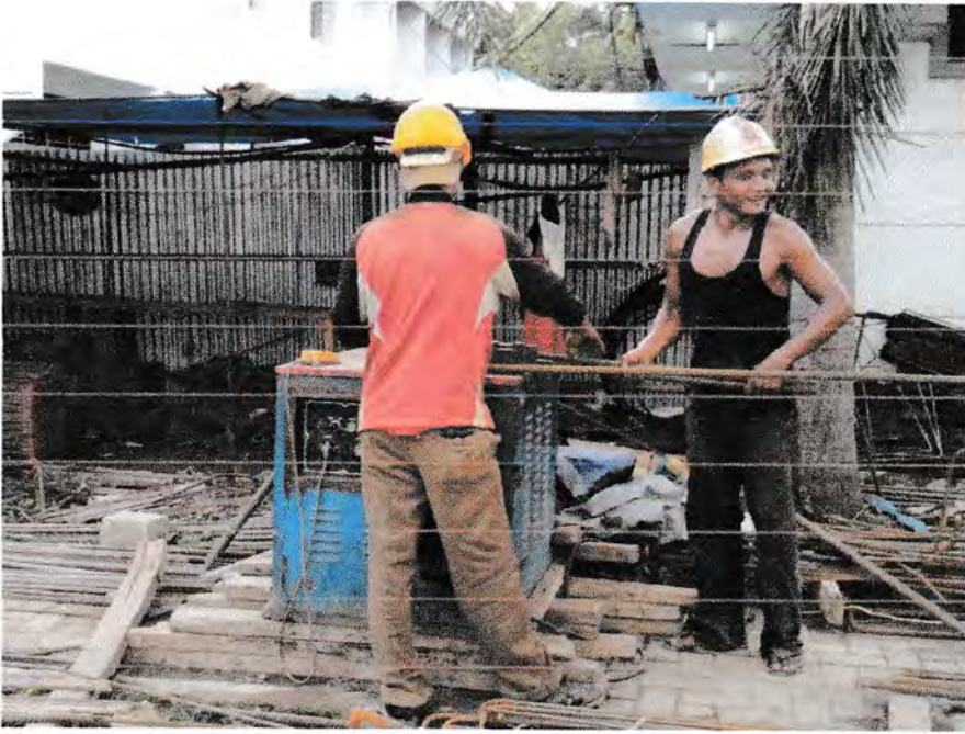
Gambar 3.17 Bar Bender (Pembengkok Tulangan)
