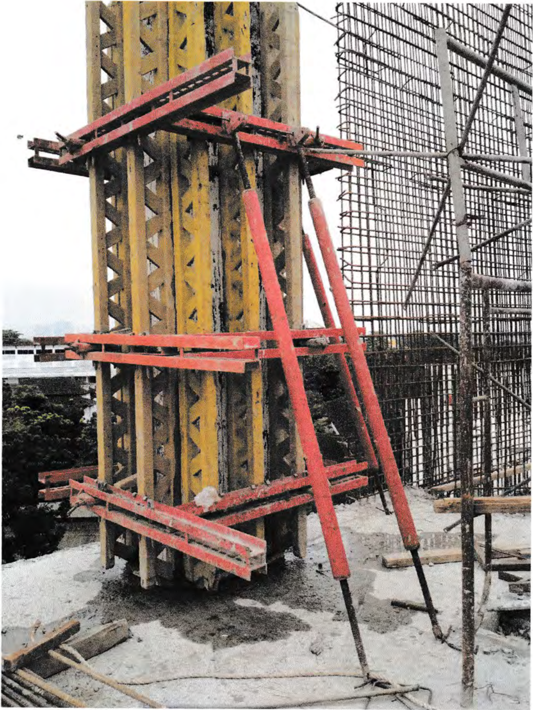
Gambar 10 : Bekisting Peri Kolom Lokasi : Universitas Negeri Medan
