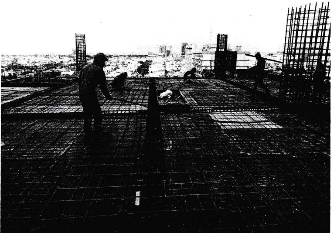
Gambar 2.25 (e) Pemasangan Tulangan
