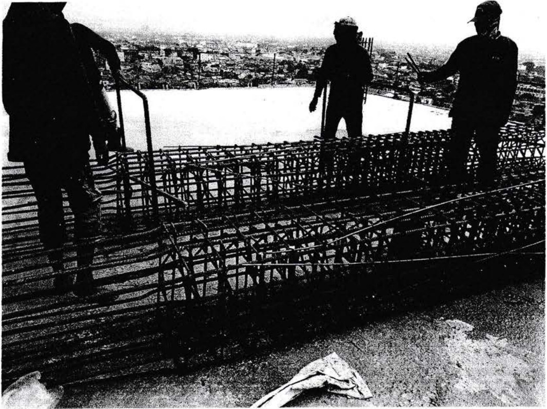
Gambar 2.23 Penulangan Kolom
