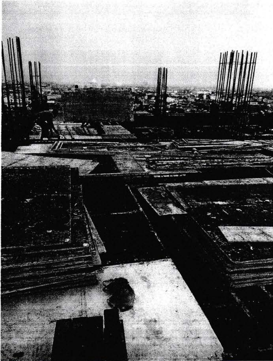
Gambar 2.25 (d) Pemasangan bekisting
