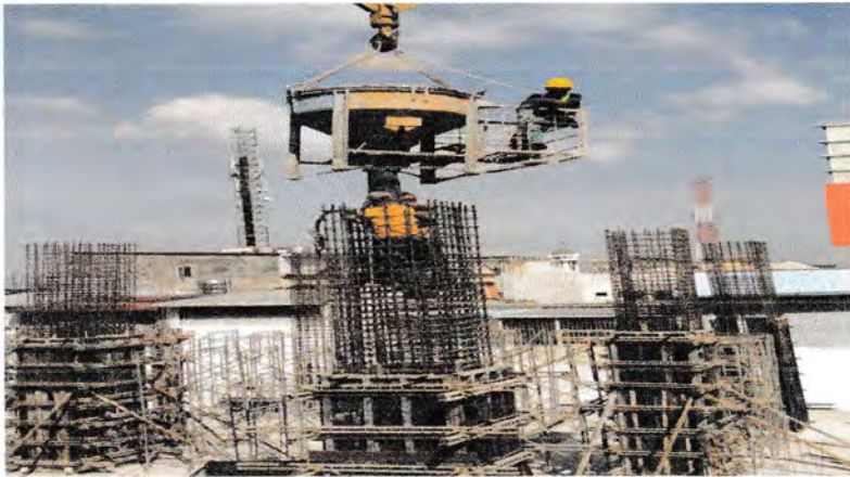
Gambar bucket cor Sumber : Data lapangan 2017
