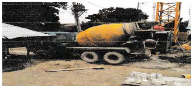
Gambar Ready Mix Sumber :Proyek 2017
