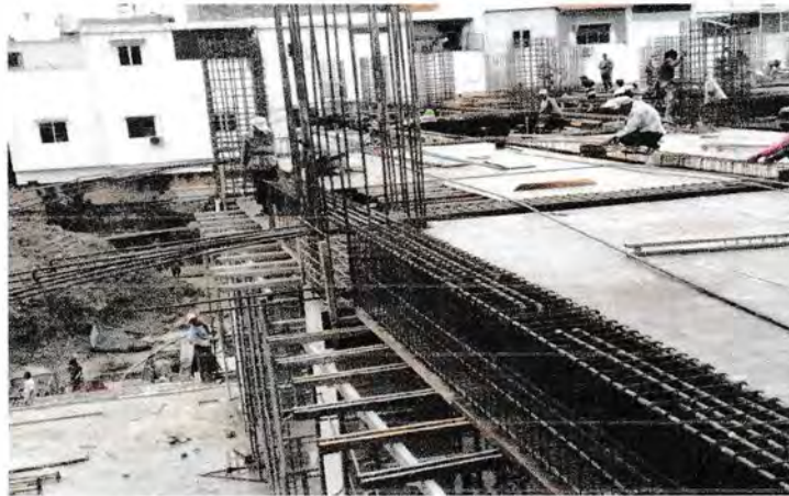
Gambar bekisting dan cetakan Sumber : Proyek 2017
