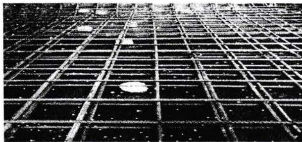
Gambar 3.25 : Pemasangan beton decking dan kursi tulangan Sumber : dokumentasi lapangan
