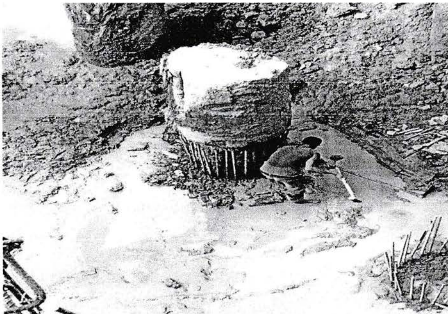
Pekerjaan Pemotongan Pondasi Bored Pile
