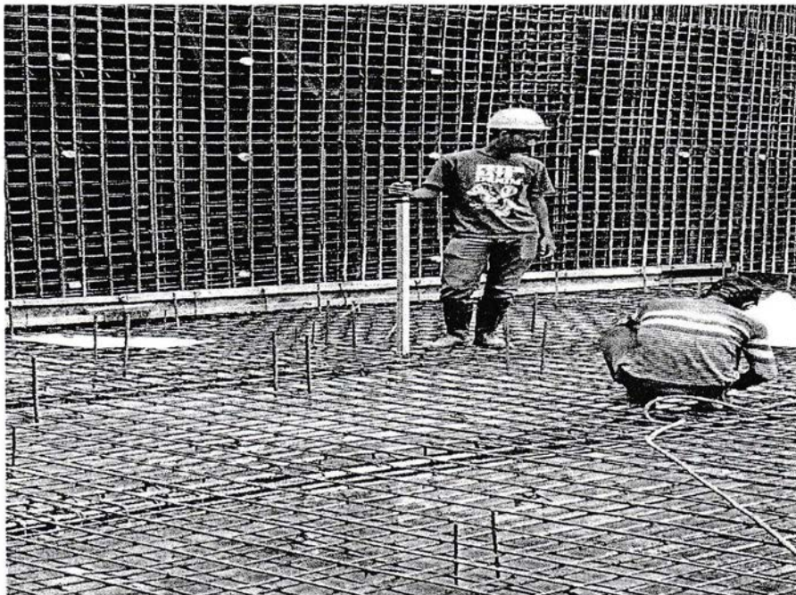
Pekerjaan Dinding Basement
