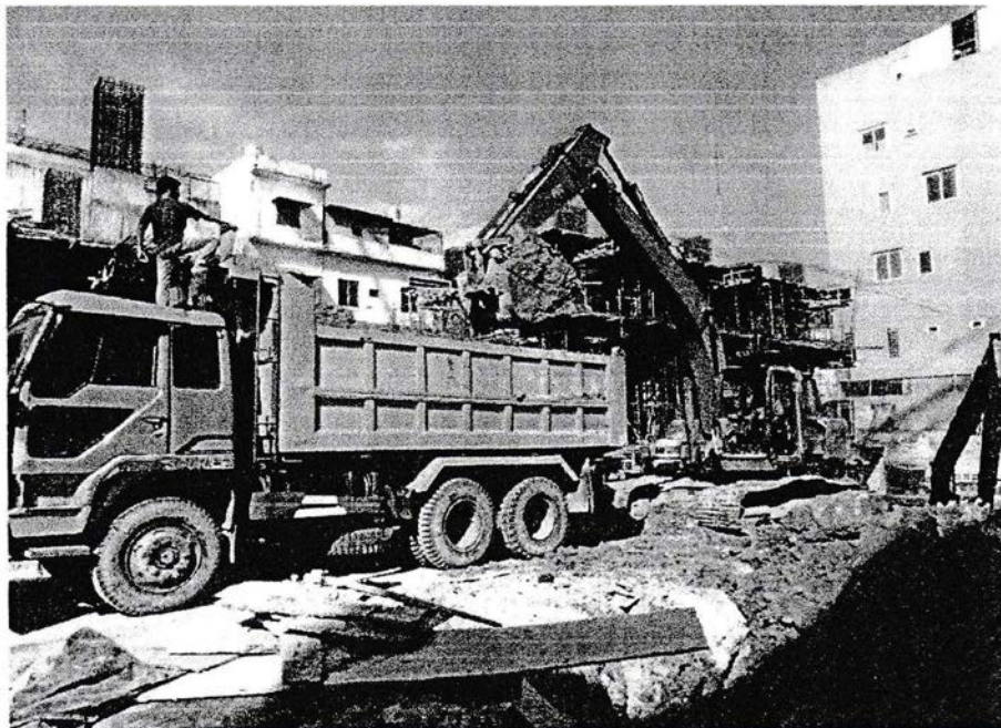
Proses Pembuangan Tanah Galian ke Truk
