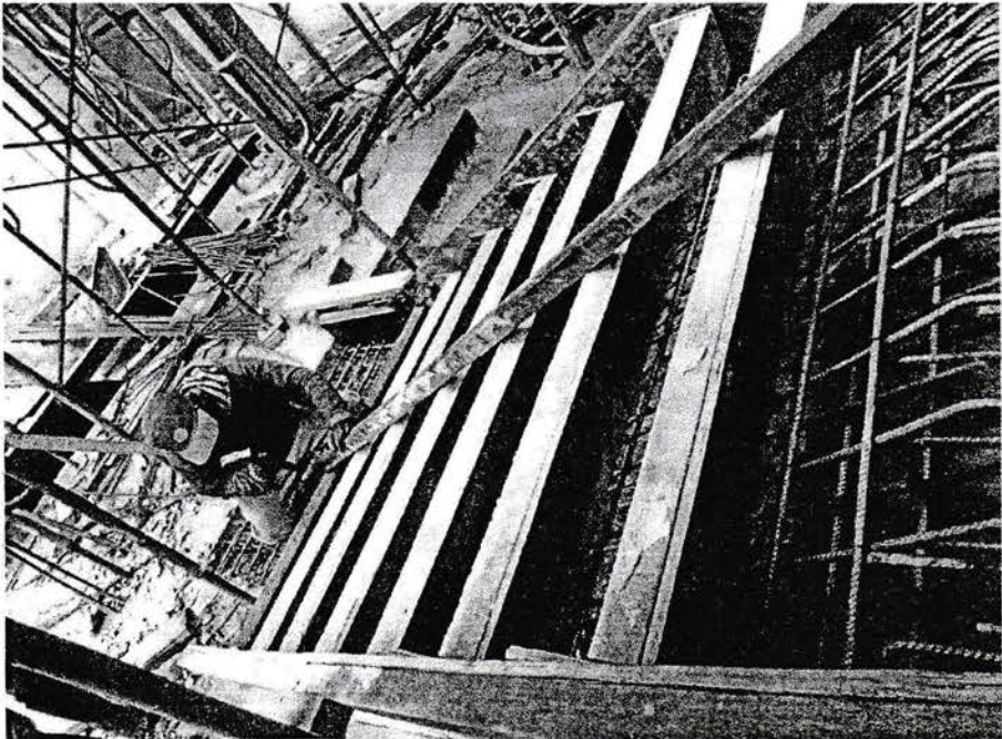
Pemasangan Bekisting Tangga
