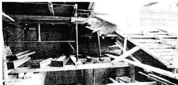
Gambar 3.21 : Pekerjaan perancah pada kontruksi tangga Sumber : dokumentasi lapangan
