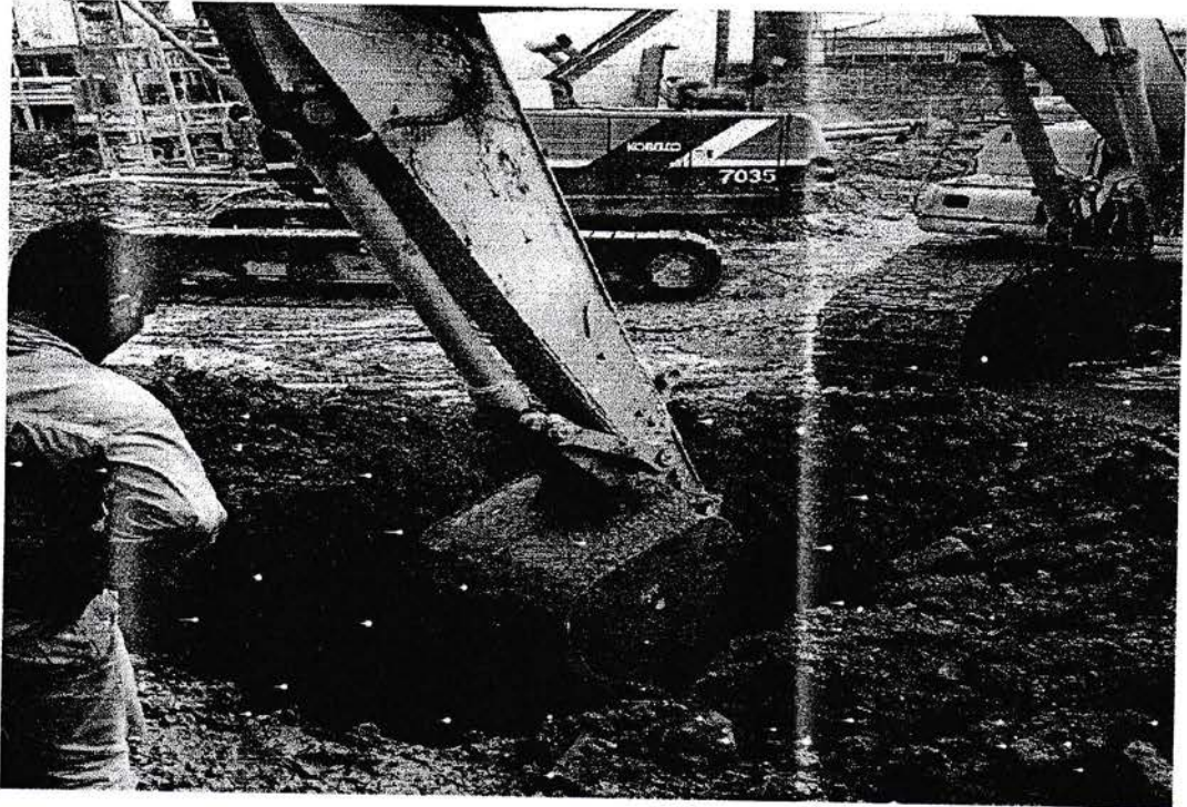
Gambar. Penggalian Lubang Pondasi
