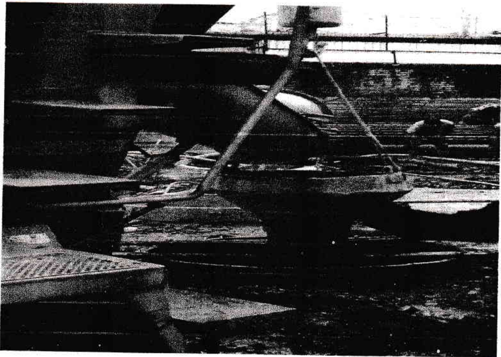
Gambar Proses Pengecoran
