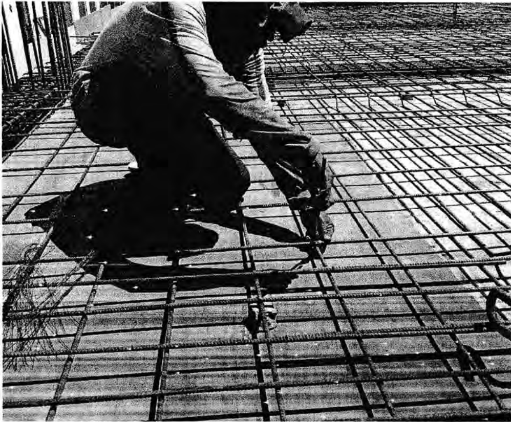
Gambar 3.14 Pembesian Plat Lantai
