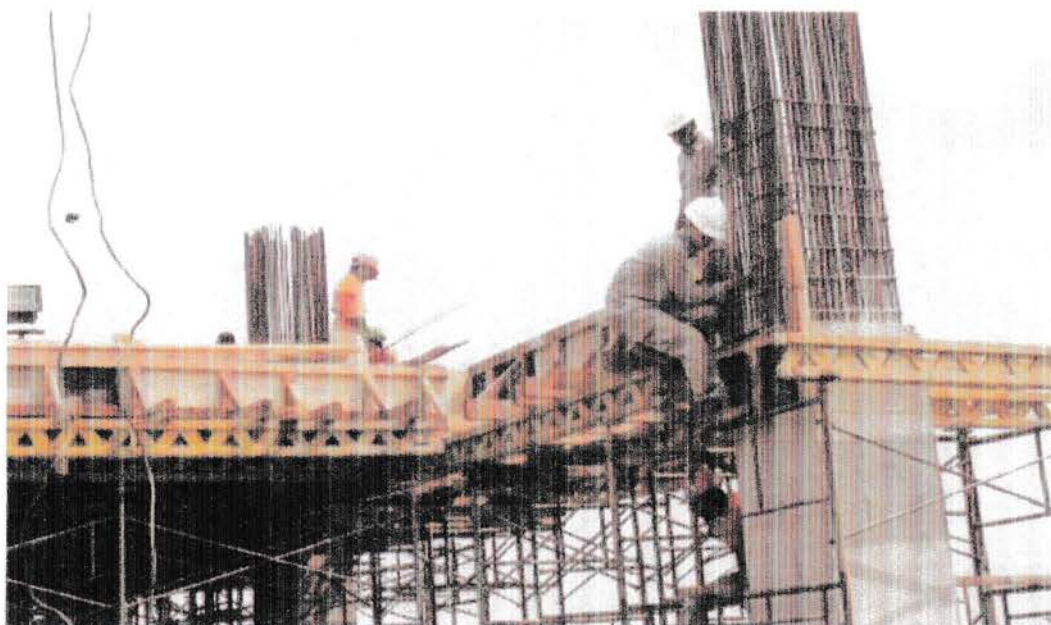
Gambar 21 : Pengecekan pembesian
