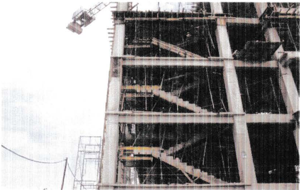
Gambar 20 : pasangan tangga tiap lantai
