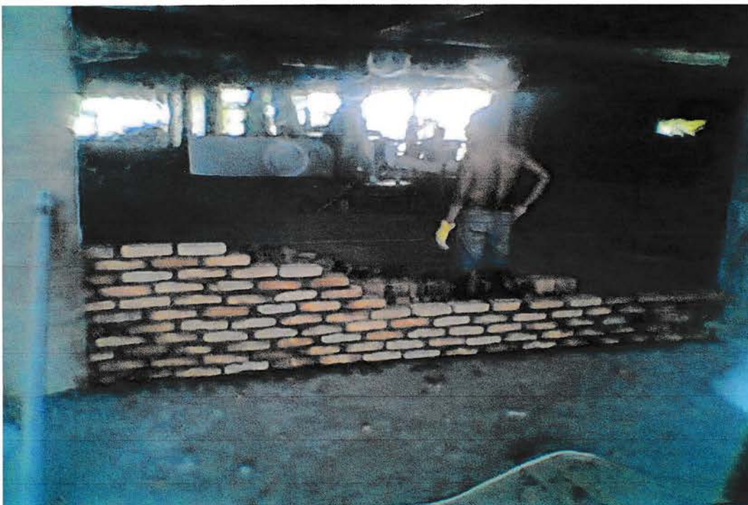
Gambar.3.2.3.6. Pekerjaan Pemasangan Batu Bata
