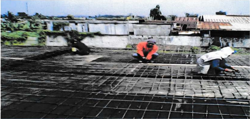
Gambar 3.2.3.3. Pekerjaan pemasangan pembesian
