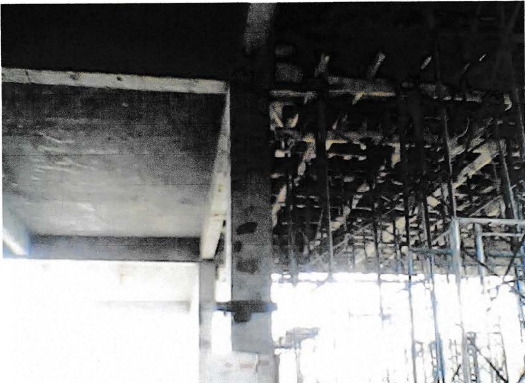
Gambar 3.2.3.5. pembongkaran bekisting pada plat lantai
