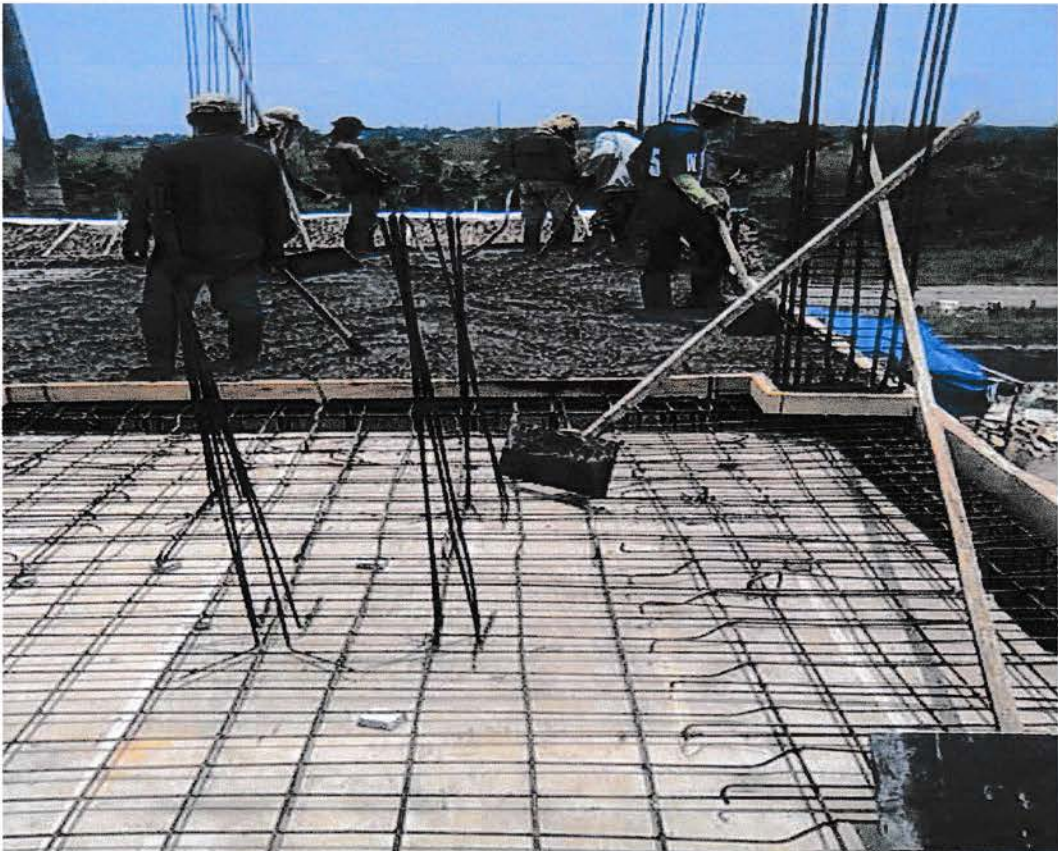
Gambar 3.2.3.4. Pekerjaan pengecoran
