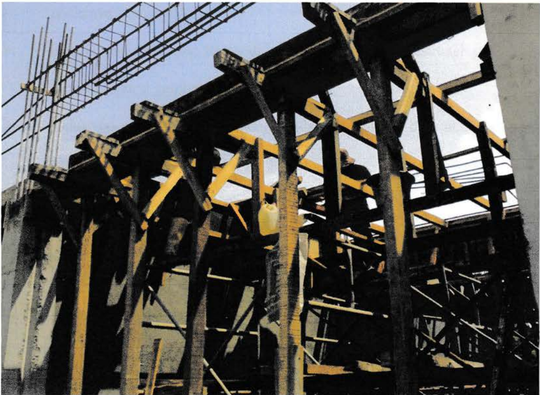
Gambar 3.2.3.1. Pekerjaan pemasangan perancah
