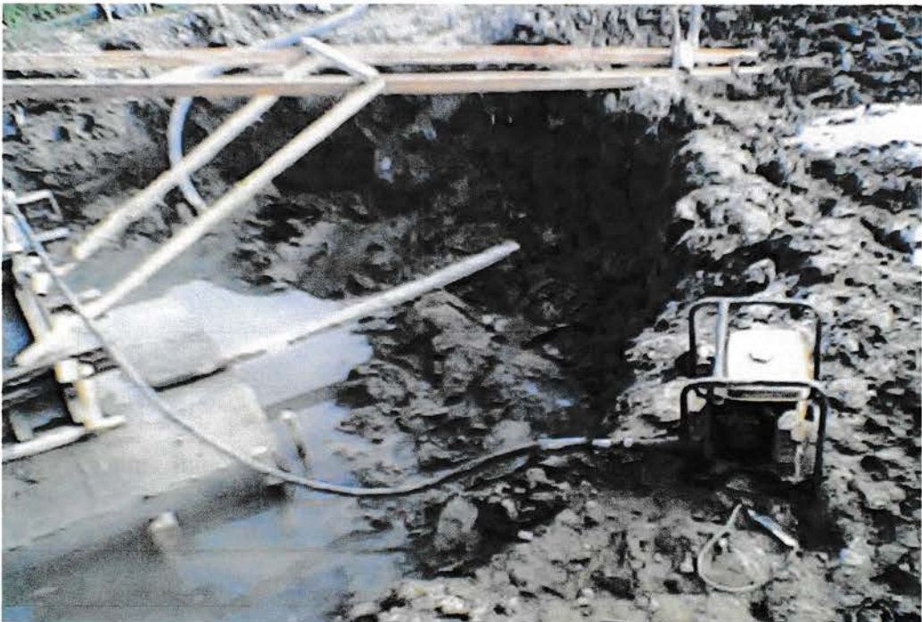
Gambar. 3.2.1.3. Alat Pematat Beton Pada Pengecoran
