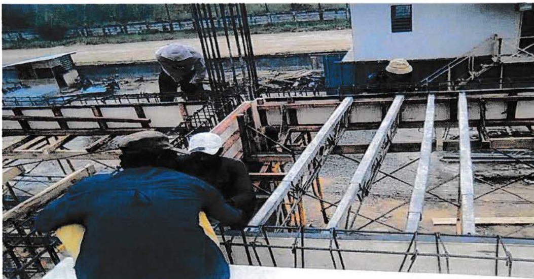
Gambar 3.2.3.2.b. Pemasangan bekisting pada balok dan lantai
