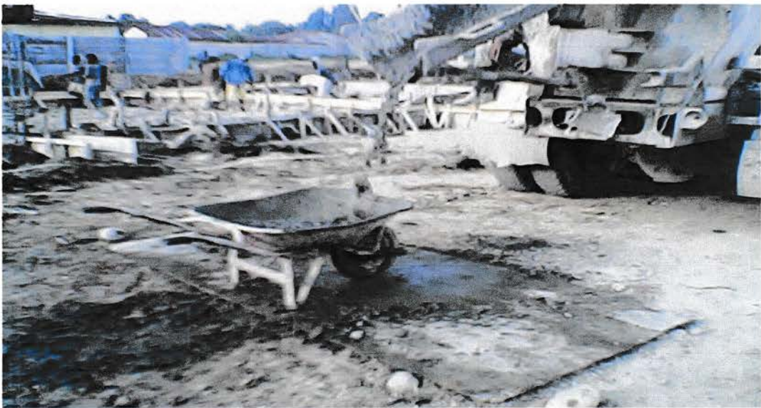
Gambar. 3.2.1.4. Alat Pengangkut Beton Pada Pengecoran
