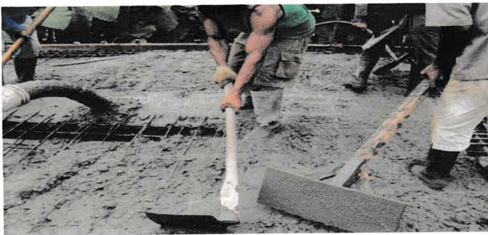
Gambar. 3.2.1.7. Alat Peratakan beton Pada Pengecoran
