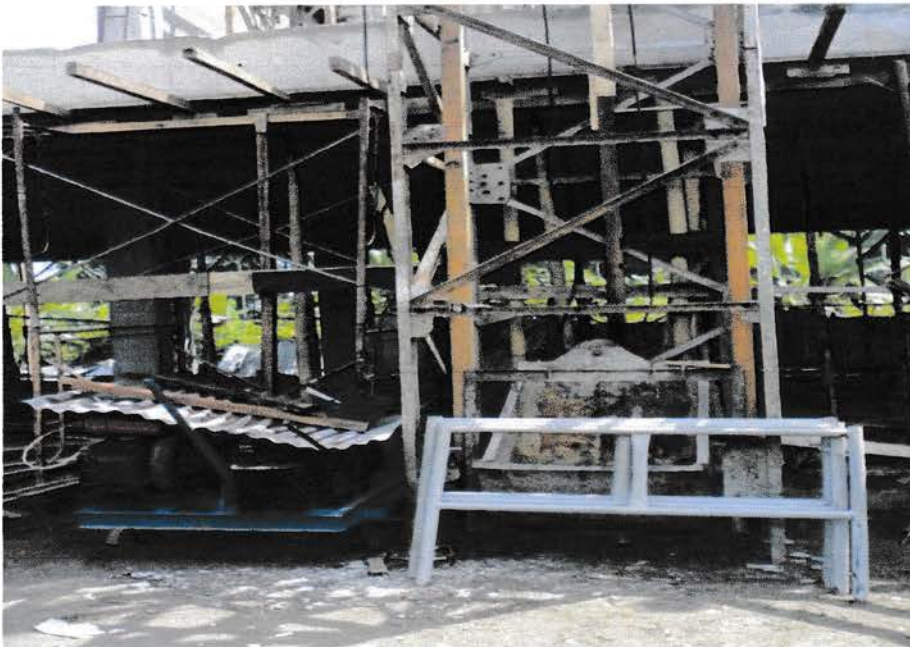
Gambar 3.2.1.2. Alat Pengangkut Beton Pada Pengecoran
