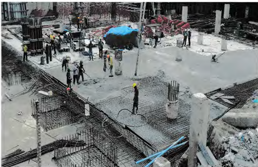
Gambar 4.27 Proses pengecoran plat lantai dan kolom Sumber : Lokasi proyek 2016
