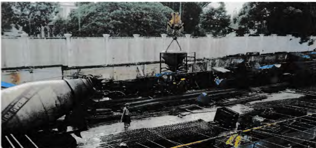
Gambar 4.13 Bucket Cor Sumber : Lokasi proyek 2016
