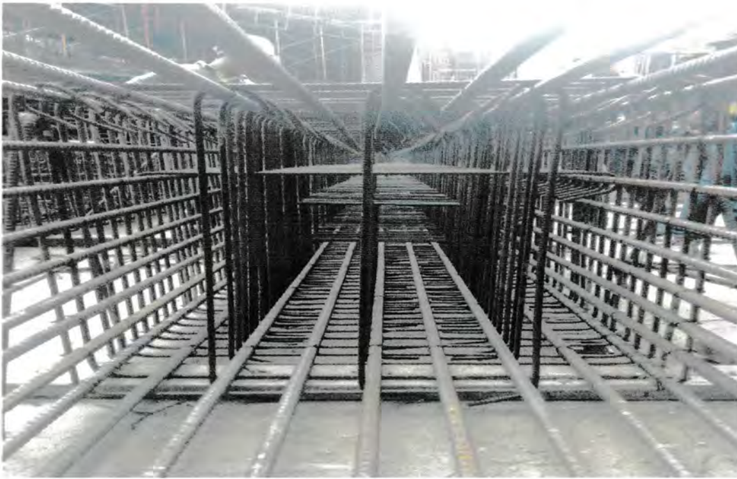
. Gambar 4.22 Tulangan yang sudah di rakit Sumber : Lokasi proyek 2016
