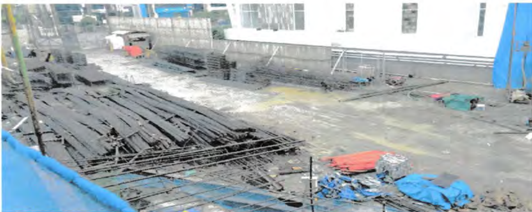
Gambar 4.11 Pembesian Lantai Sumber : Lokasi proyek 2016
