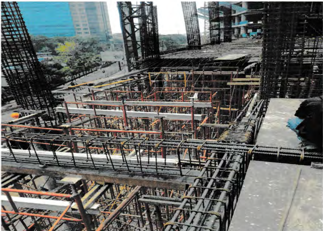
Gambar 5.8 Scaffolding Lantai Dan Balok Sumber : Lokasi proyek 2016
