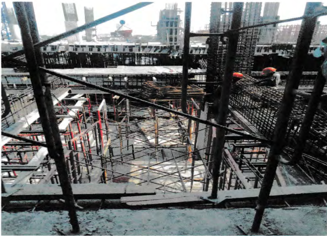
Gambar 5.3 Scaffolding Lantai dan kolom Sumber : Lokasi proyek 2016
