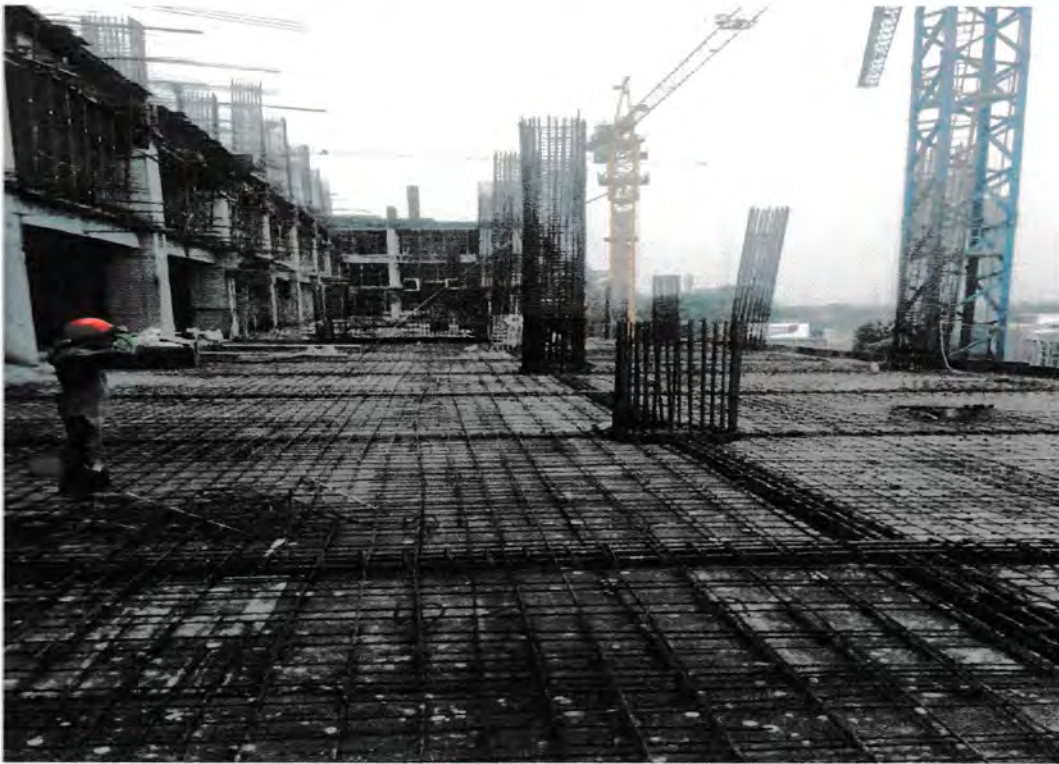
Gambar 5.1 Pembesian Lantai Sumber : Lokasi proyek 2016
