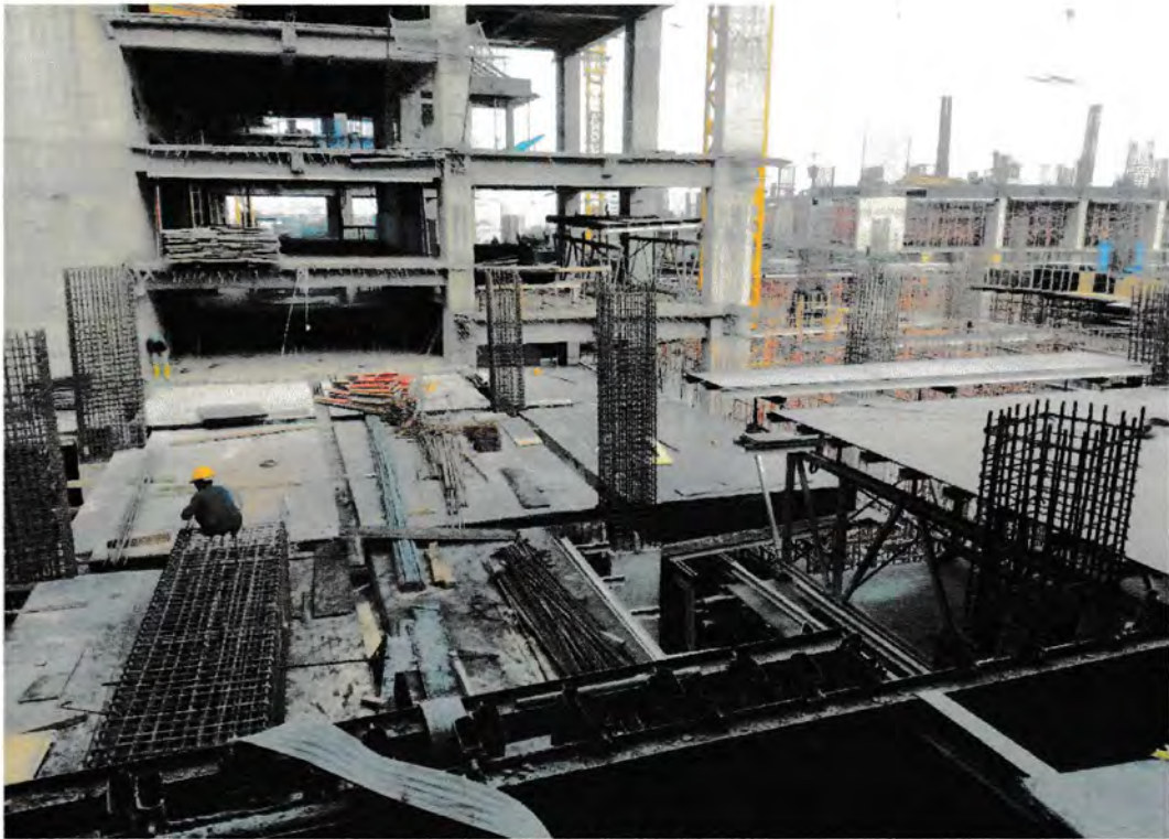
Gambar 5.5 Bekisting Lantai Sumber : Data lapangan ,2016
