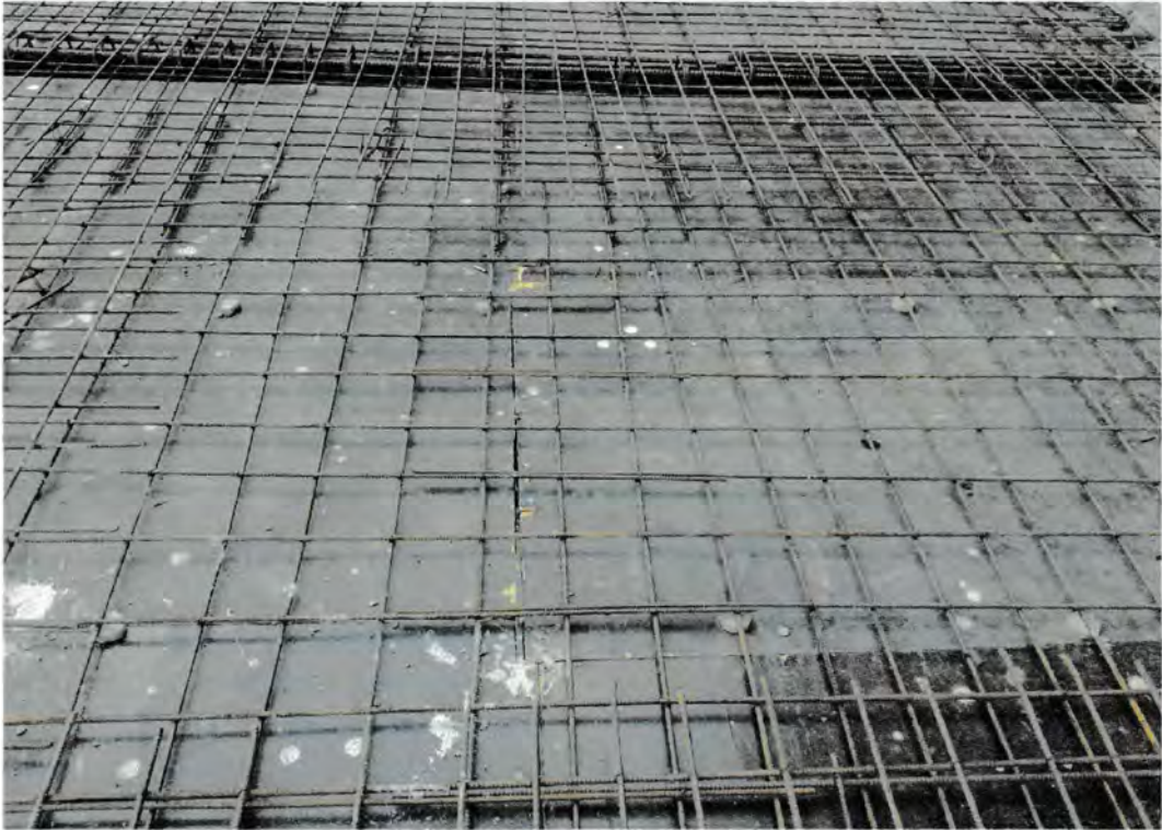
Gambar 5.7 Pembesian Lantai Sumber : Lokasi proyek 2016
