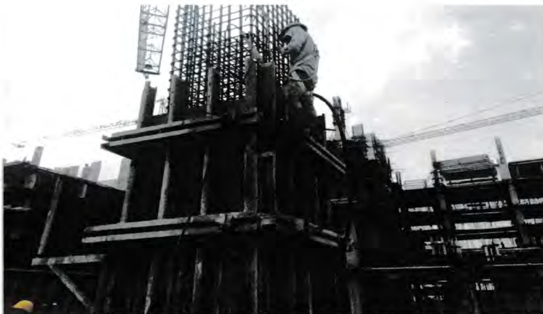
Gambar 4.24 Tulangan kolom yang sudah di pasang bekisting Sumber : Lokasi proyek 2016
