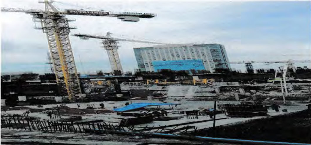
Gambar 4.12 Tower Crane Sumber : Lokasi proyek 2016
