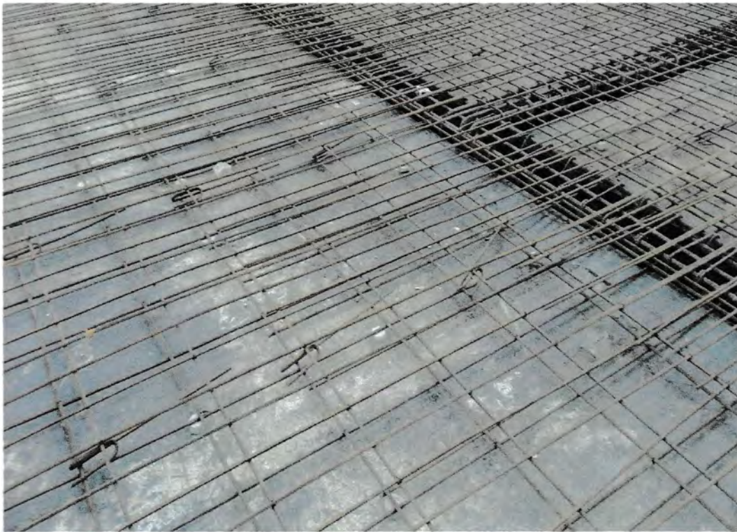
Gambar 4.28 Pekerjaan Pembesian Plat Lantai dan kolom Sumber : Lokasi proyek 2016
