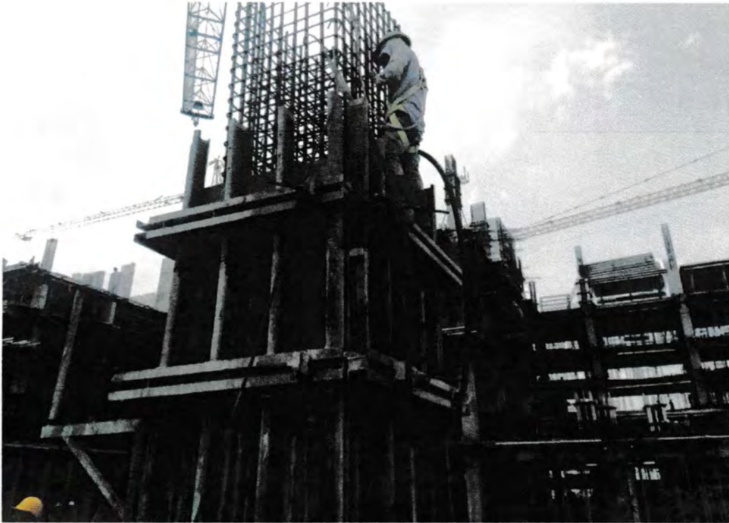
Gambar 5.11 Pemasangan bekisting kolom Sumber : Lokasi proyek 2016
