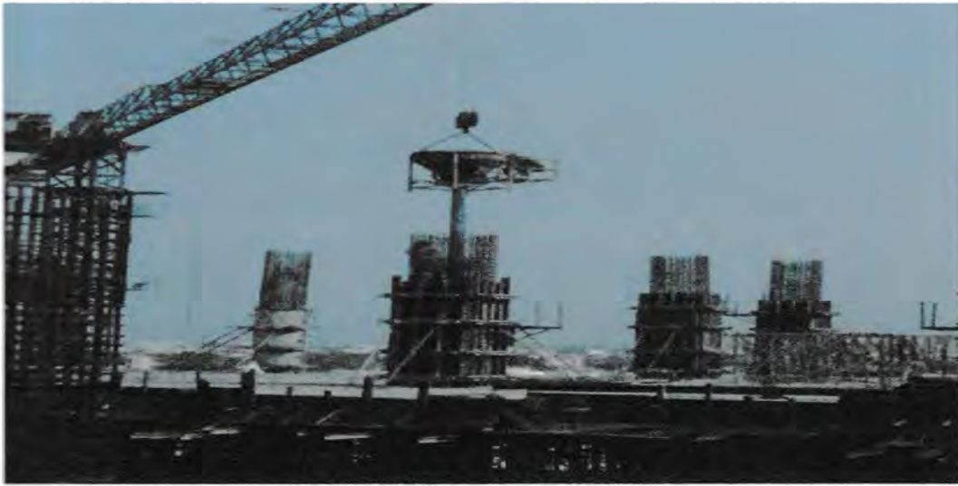
Gambar 4.25 Proses pengecoran kolom Sumber : Lokasi proyek 2016
