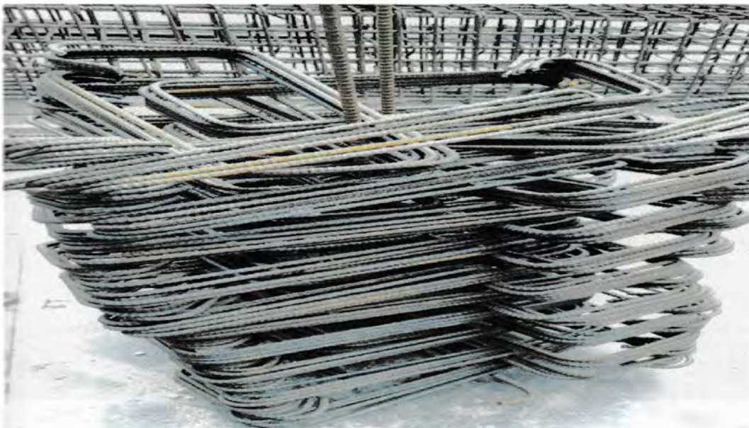
Gambar 4.21 Tulangan yang sudah di bending Sumber : Lokasi proyek 2016
