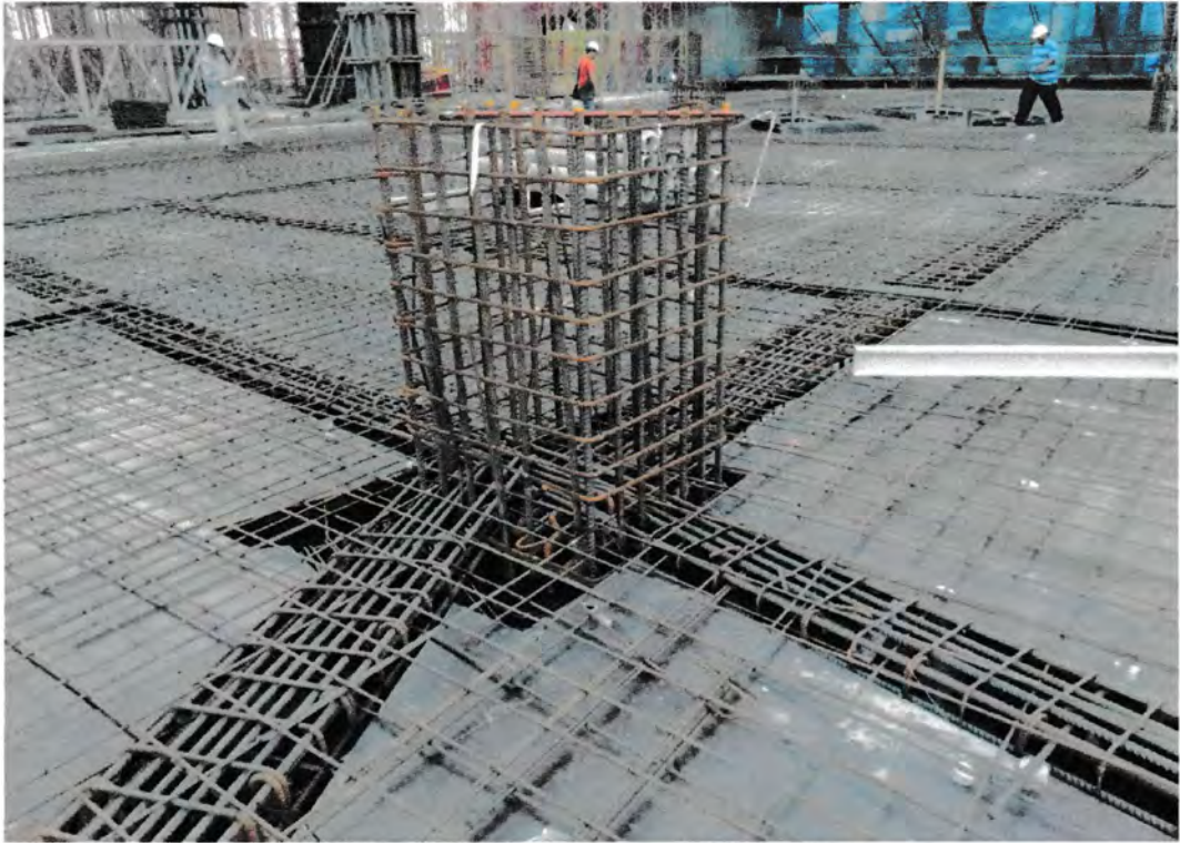
Gambar 5.9 Pembesian kolom, balok dan lantai Sumber : Lokasi proyek 2016
