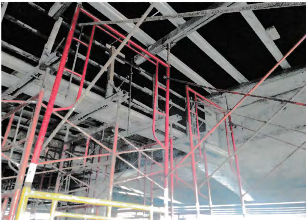
Gambar 5.4 Scaffolding Lantai dan balok Sumber : Lokasi proyek 2016
