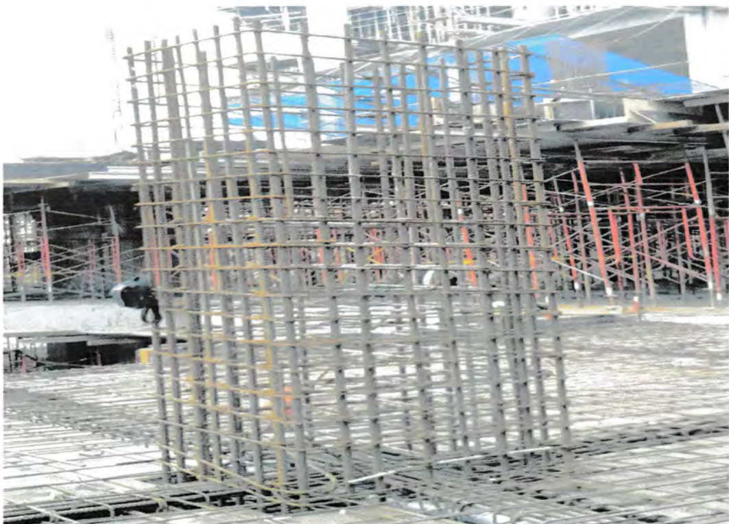
Gambar 5.10 Pembesian kolom Sumber : Lokasi proyek 2016
