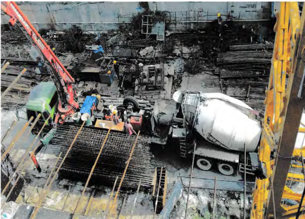
Gambar 4.5 Beton ready mix Sumber : Lokasi proyek 2016
