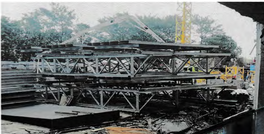
Gambar 4.15 Scaffolding Sumber : Lokasi proyek 2016
