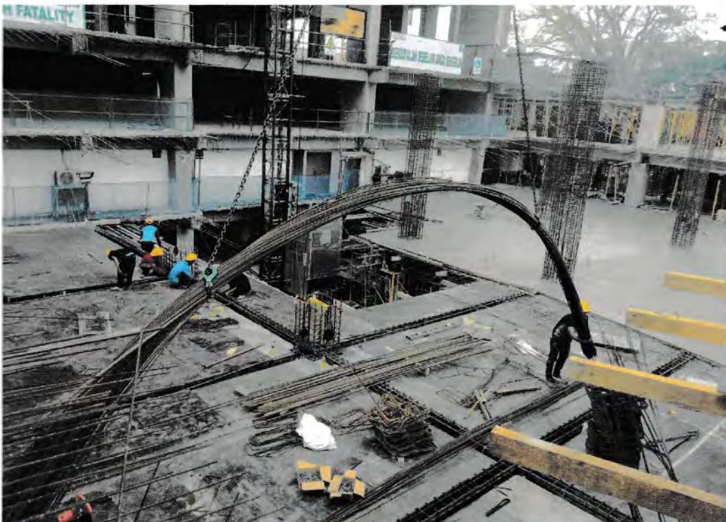
Gambar 5.2 Pembesian Lantai Sumber : Lokasi proyek 2016
