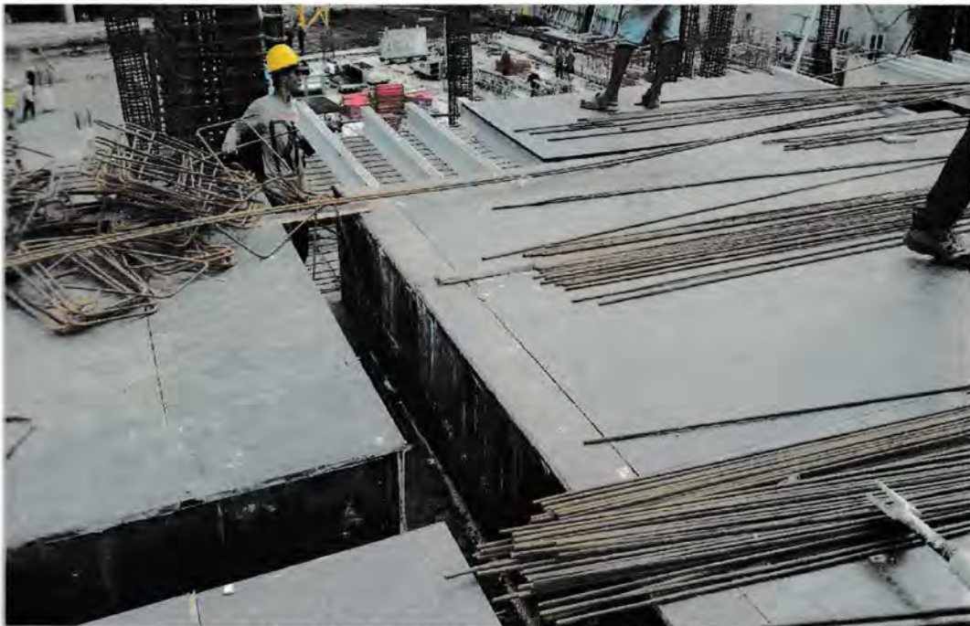
Gambar 4.26 Bekesting Plat Lantai dan balok Sumber : Lokasi proyek 2016
