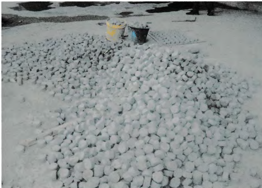
Gambar 4.28 Beton tahu untuk dudukan pembesian plat lantai Sumber : Lokasi proyek 2016
