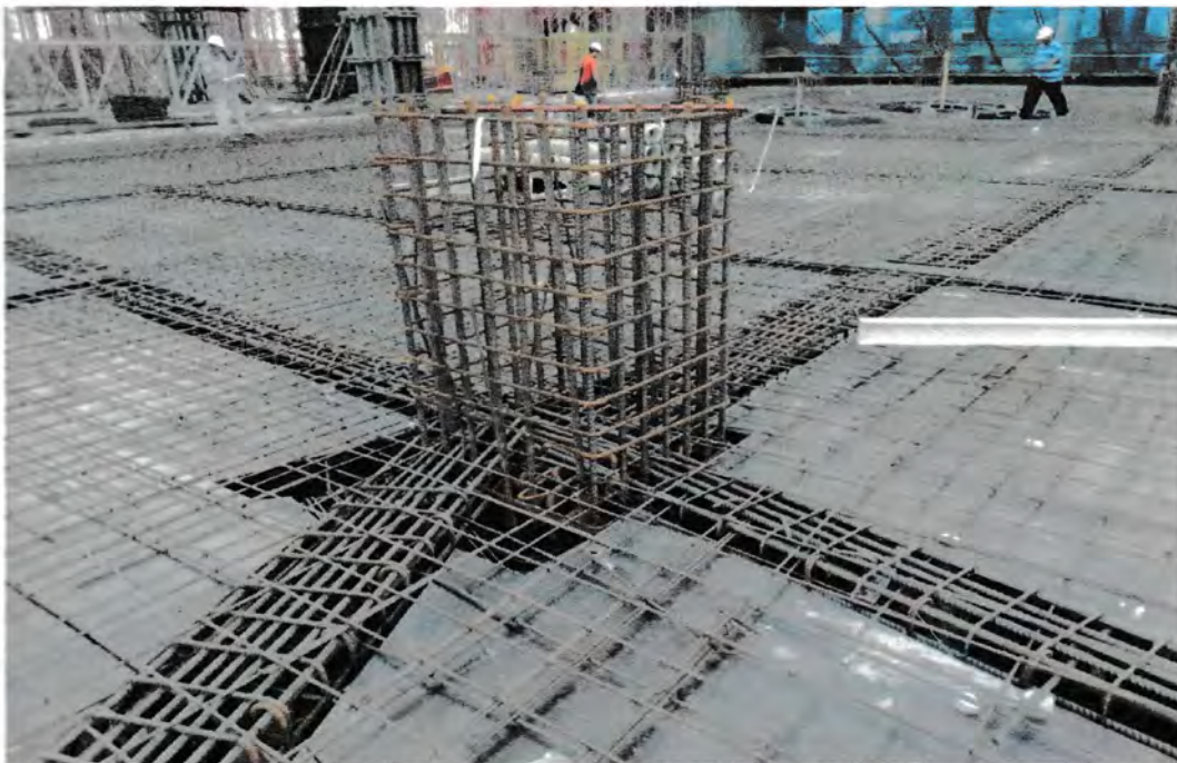
Gambar 4.23 Tulangan kolom yang sudah di pasang pada grid - as Sumber : Lokasi proyek 2016
