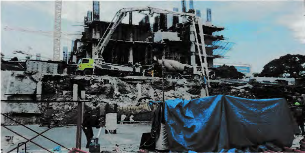
Gambar 4.14. Concret Pump Sumber : Lokasi proyek 2016
