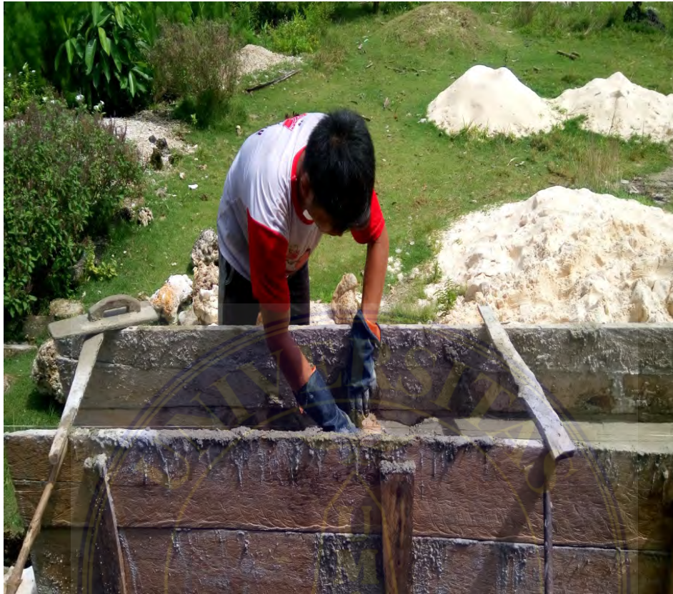
Foto; Proses Pengerjakan Bangunan Tembok Halaman Desa
