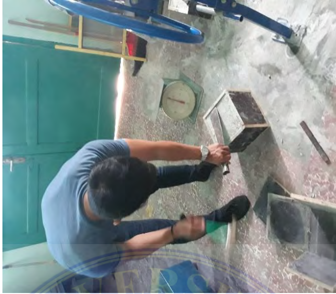
Gambar 11. Pembongkaran bekisting
