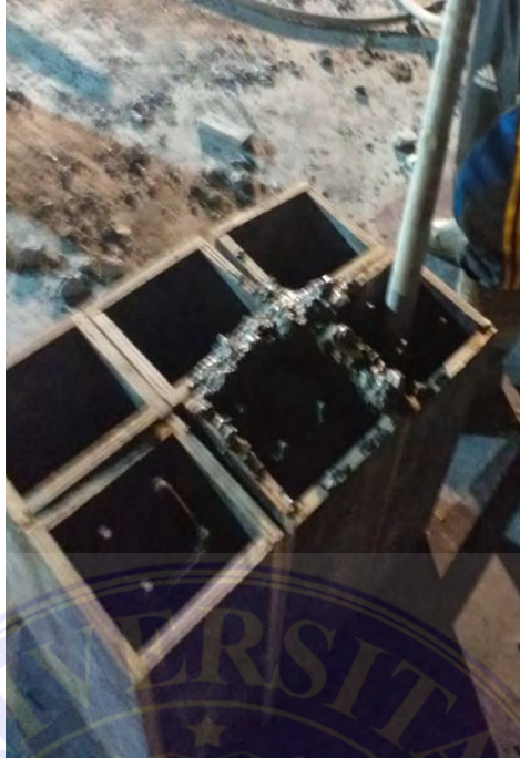
Gambar 9. Perojokan campuran beton
