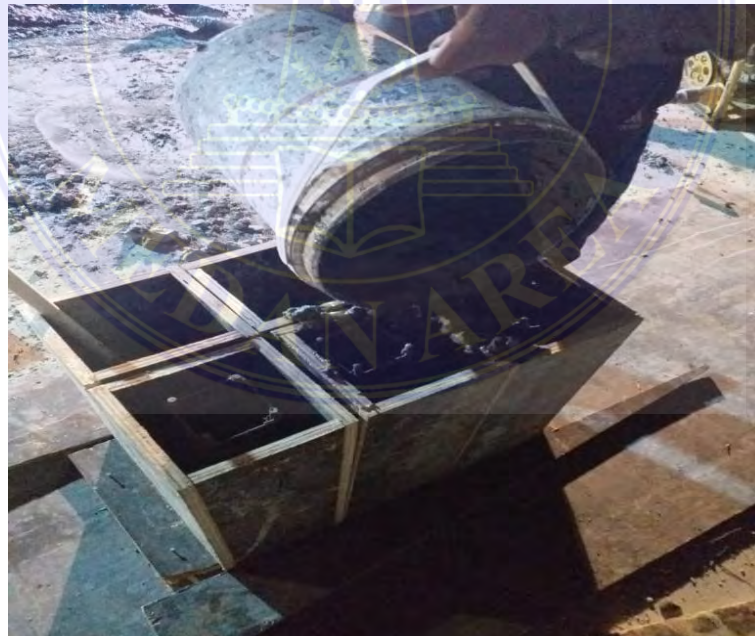
Gambar 8. Penuangan campuran beton
