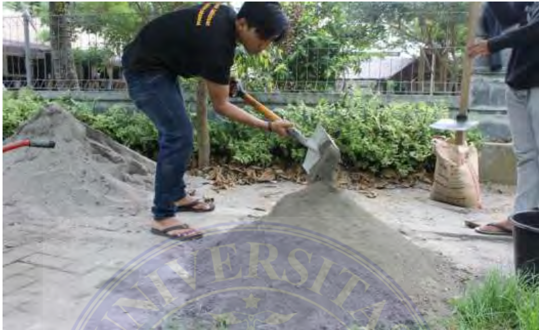
2. Proses Pencampuran Semen Portland tipe I dengan Pasir
