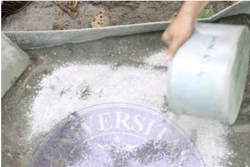
13. Pencampuran kulit kerang yang telah halus dengan semen dan pasir
