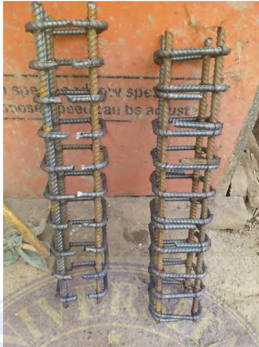
Gambar 17. Perbedaan menggunakan sengkang “U” dengan sengkang konvensional
