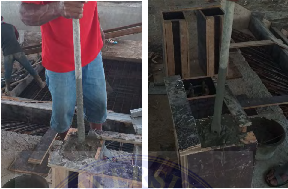
Gambar 21. Perojokan campuran beton
