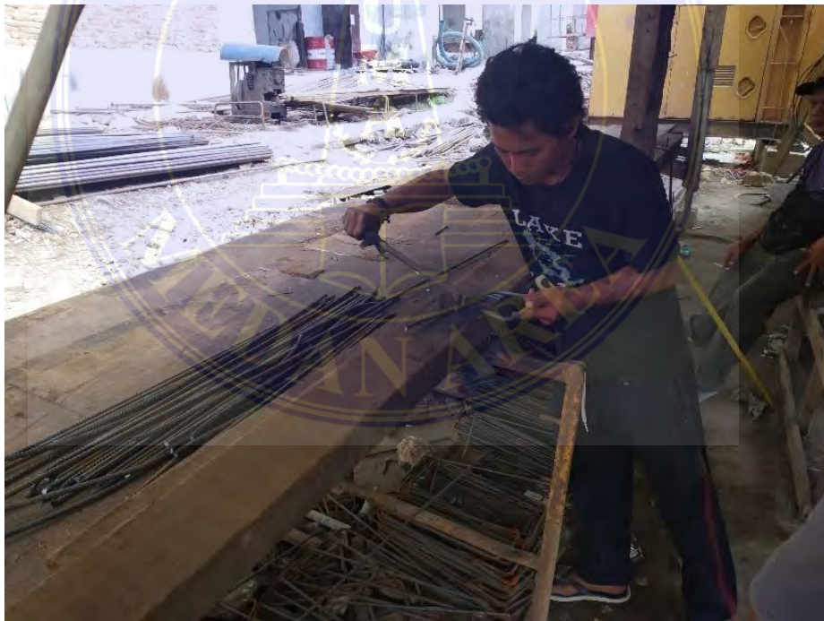
Gambar 14. Tempat pembengkokan tulangan
