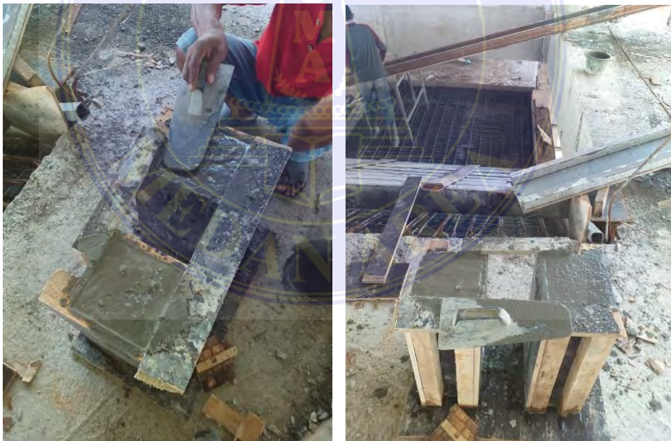
Gambar 22. Perataan campuran beton
