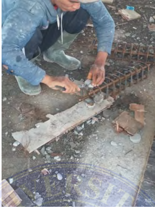
Gambar 19. Pemasangan tahu beton
