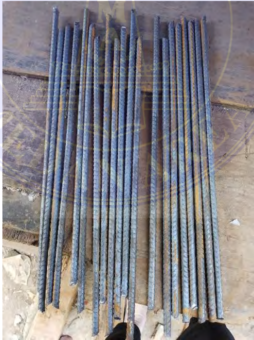
Gambar 12. Tulangan setelah dipotong
